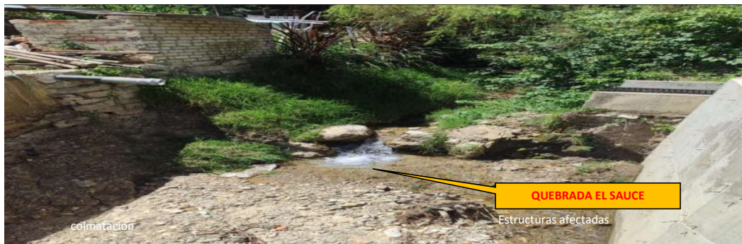
Fig. 01,02: Cauce Qda El Sauce. Tramo crítico. Notese quebrada colmatada, incluso se ha reducido y/o estrangulado el ancho de la quebrada, que en una lluvia intensa afectara ambas viviendas existentes en ambos márgenes; que puede afectar una inundación en esta zona.
